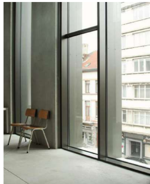
Подвійна висота навісного фасаду Double height glass facade
