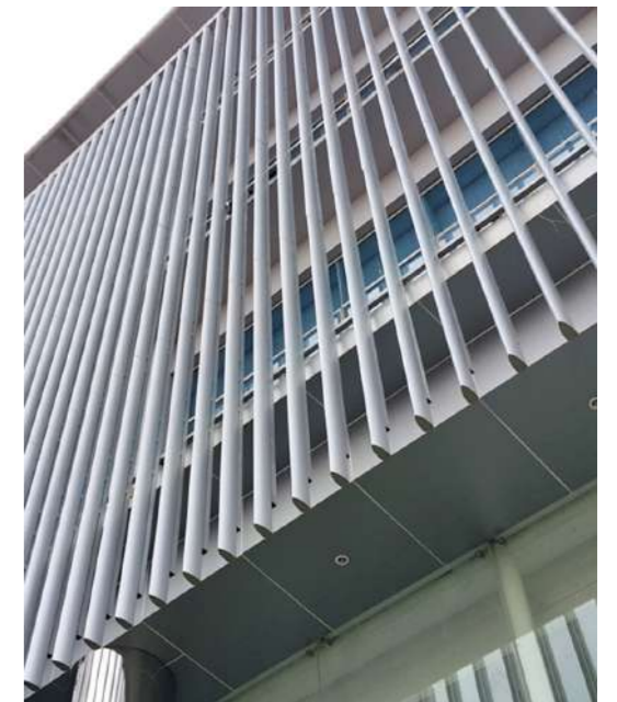
Облицювання з гофрованого металу Aluminium lamell facade and outdoor ceiling
